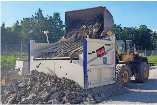
SBR 4 in Betrieb mit Sensorautomatik und 5,5 m 3 fassendem Radlader Komatsu WA 480.
