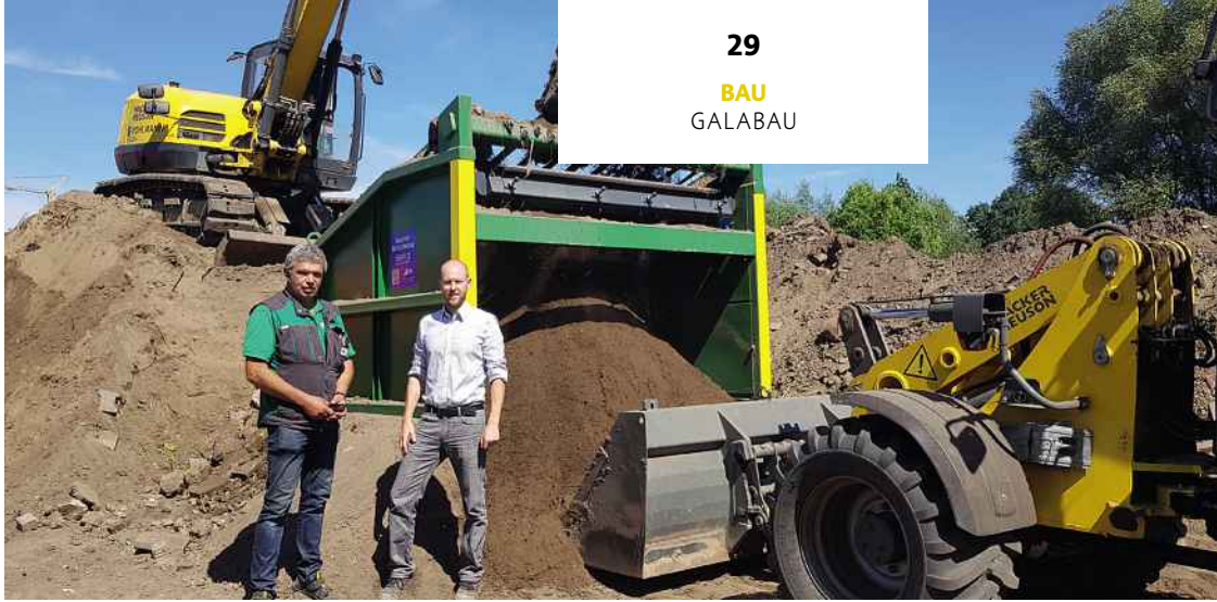
Geschäftsführer Ludger Pohlmann und Florian Schmellenkamp (BHS) vor dem Baustoff-Recyclingsieb SBR 3: Man ist zufrieden mit Siebleistung und Ergebnis. Fotos: BHS Innovationen
