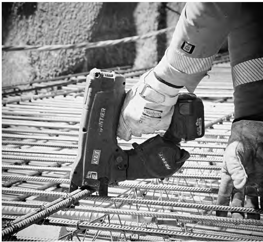
Ergonomisch wurde die RB 441T weiterentwickelt und durch das vorn liegende Drahtmagazin besser ausbalanciert. FOTO: MAX EUROPE
