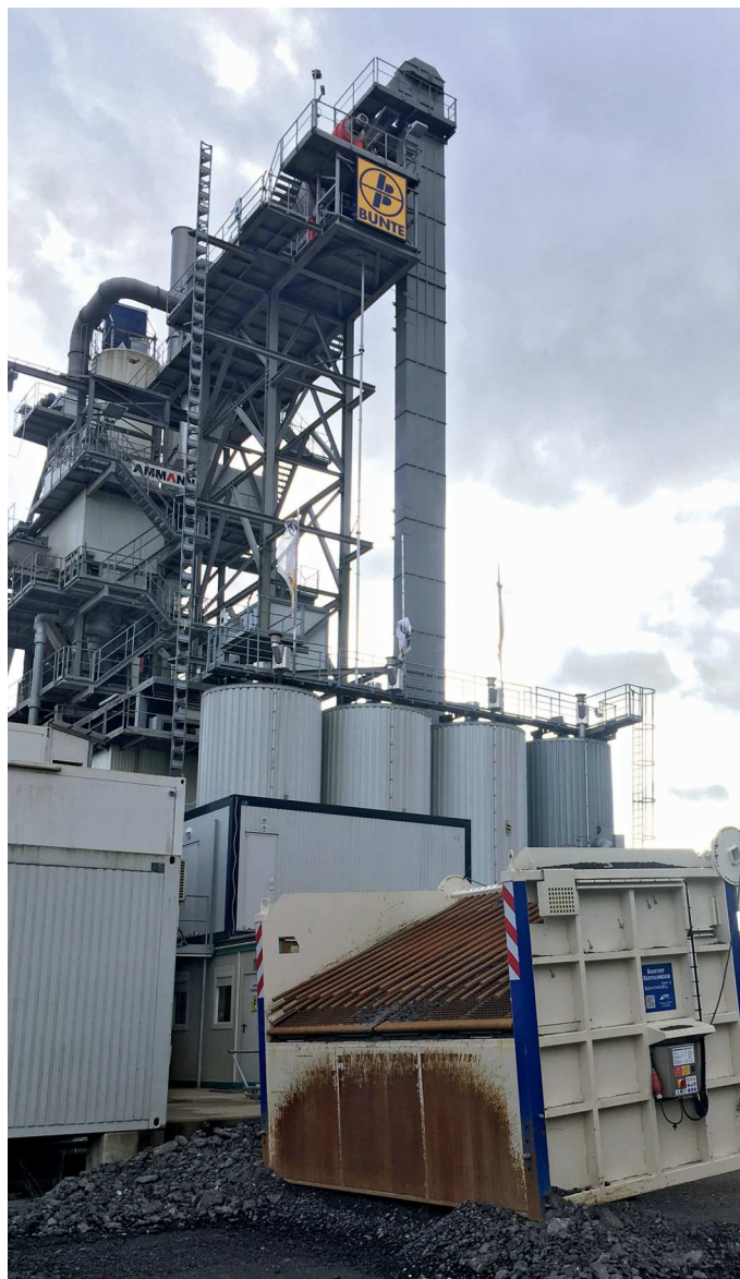
Das Asphaltmischwerk Emsbüren mit dem Baustoff-Recyclingsieb SBR 2
