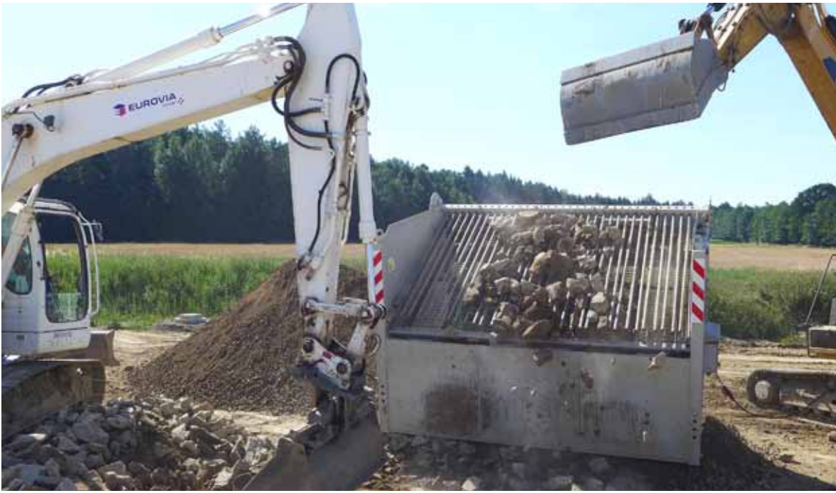
Mobiler Einsatz auf der Baustelle ermöglicht enorme Einsparung in der Logistik.
